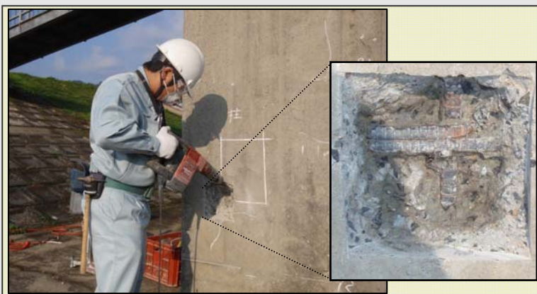
配筋調査状況
