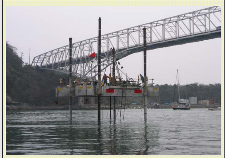
橋梁基礎調査のための海上ボーリング事例
